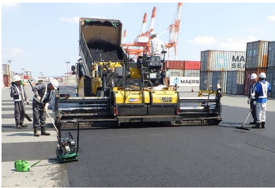
使いやすい施設の整備・補修に努めています (ヤード舗装の補修)
